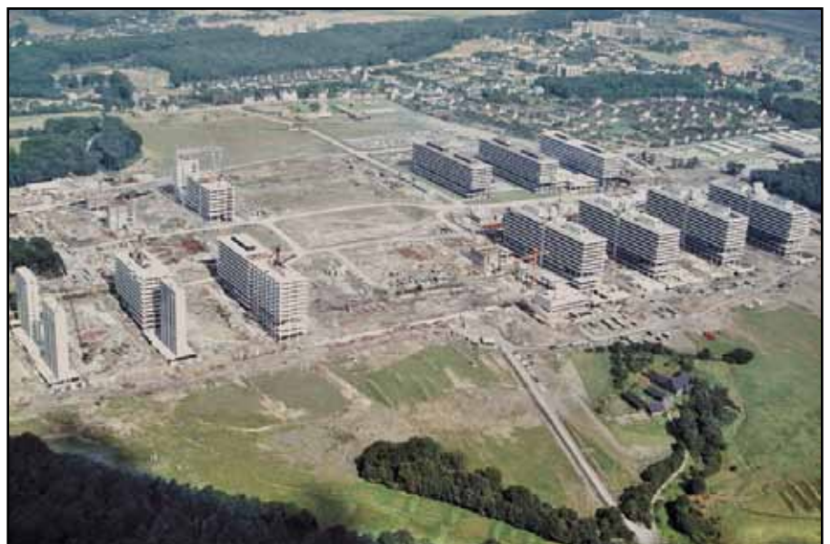
Abb. 2: Die RUB als Großbaustelle 1967 (© Stadt Bochum, Referat für Kommunikation)
